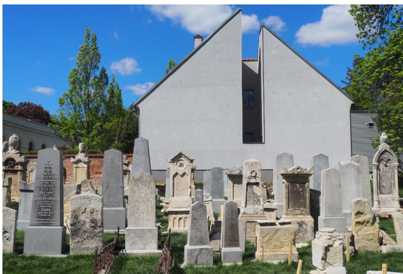
Zustand nach Sanierung 13.6.2020
